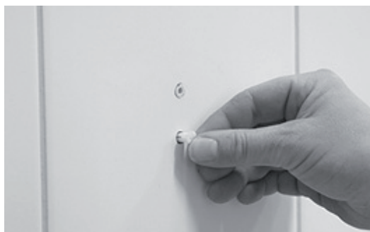
[ Bild 3.] Montera plastplugg avsedd för 5.5mm hål.
