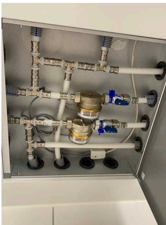
Exempel på vattenfördelarskåp med avstängningsventiler.
